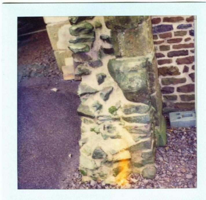
Abb. 23 (Mauerrest mit schräger Lisenenbasis am Treppenturm)
